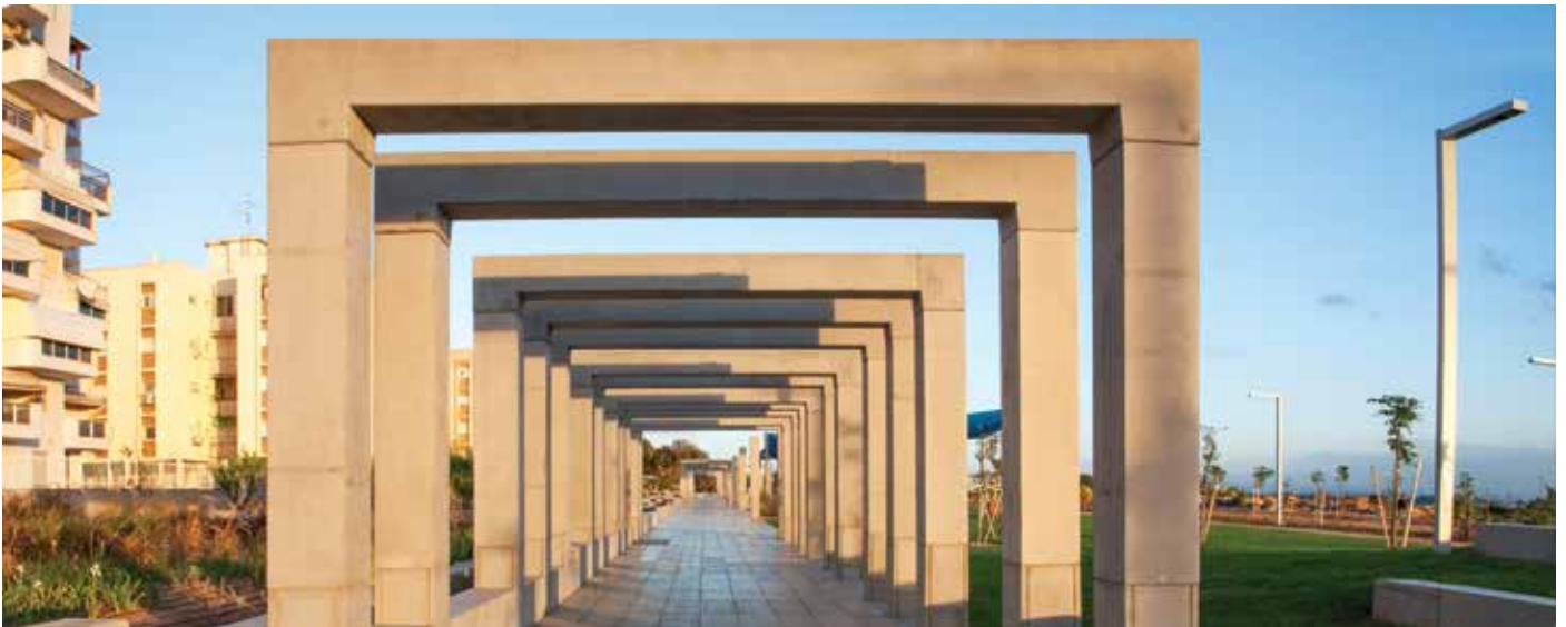
פרגולה וריצוף מבטון אדריכלי, פארק המוזיקה ראש"צ, מנעד אדריכלים.
