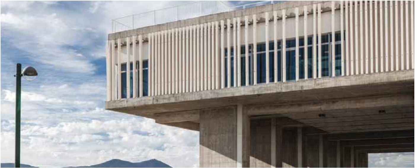
עמודים דקורטיביים בגובה 4.80 מ' מבטון אדריכלי, בית חולים זיו צפת, וינשטיין ועדיה אדריכלים.
