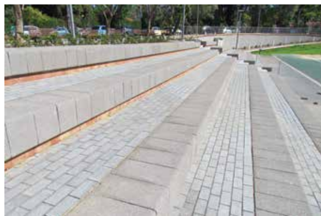
מושב אצטדיון, מרכז תרבות סביון, רוני זייברט אדריכל
