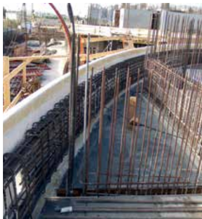
שלב ב' - הרכבה וקשירת ברזל
