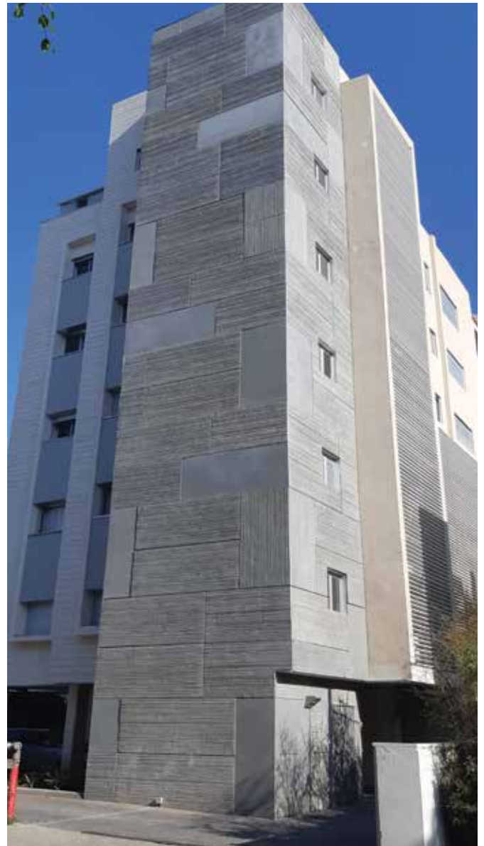
חיפוי UHPC, טשרניחובסקי, גיא אדריכלים הרצליה.
