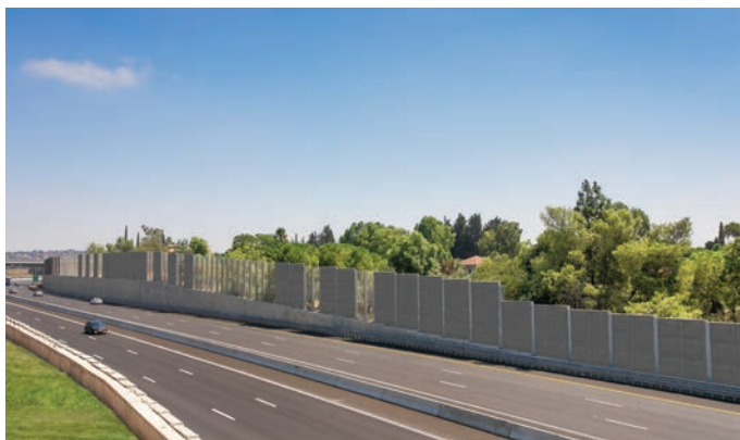
סונוליט משולב חלונות, כביש 77, אדריכל אריאל טיבי
