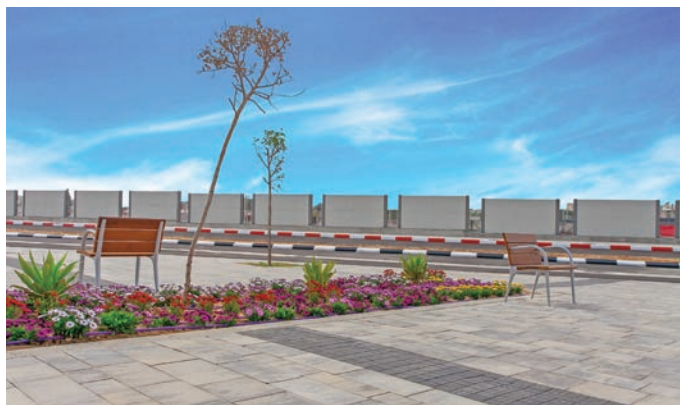
קיר אקוסטי, תחנת רכבת באר שבע, ברחנא אדריכלים
