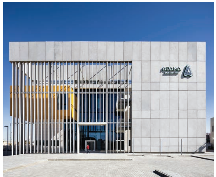
חיפוי בטון אדריכלי ואלמנט הצללה, מכתשים רמת חובב. מושלי אלדר אדריכלים.
