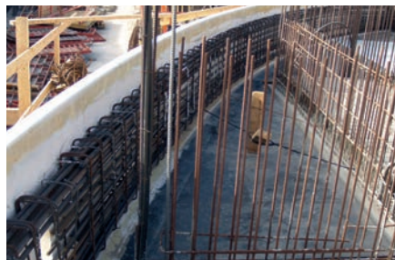
שלב ב' - הרכבה וקשירת ברזל
