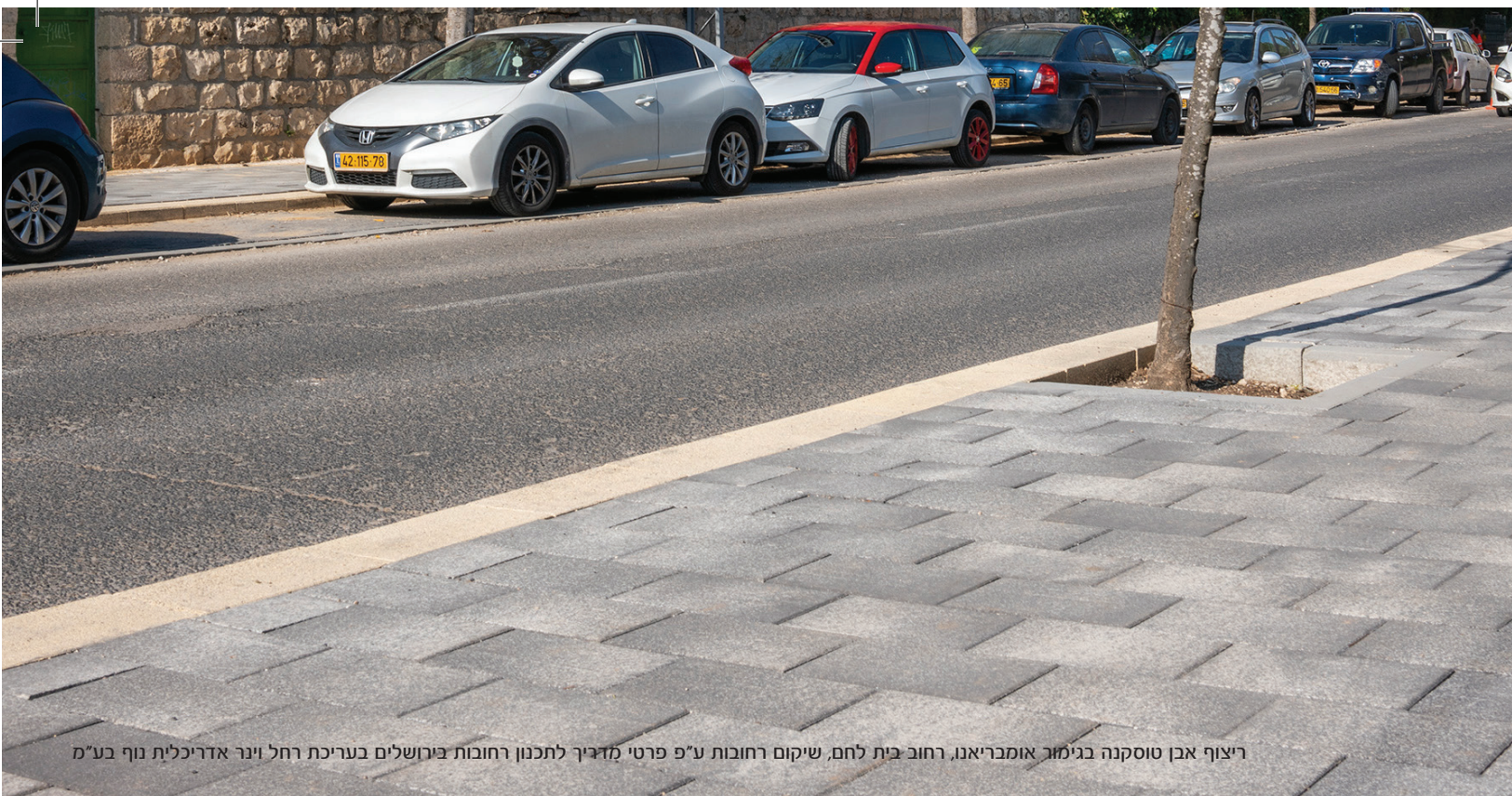
ריצוף אבן טוסקנה בגימור אומבריאנו, רחוב בצלאל, שיקום רחובות ע"פ פרטי מדריך לתכנון רחובות בירושלים בעריכת רחל וינר אדריכלית נוף בע"מ
