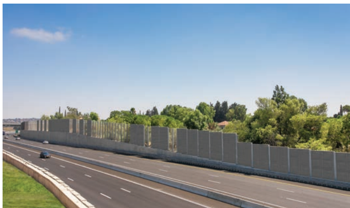
סונוליט משולב חלונות, כביש 77, אדריכל אריאל טיבי
