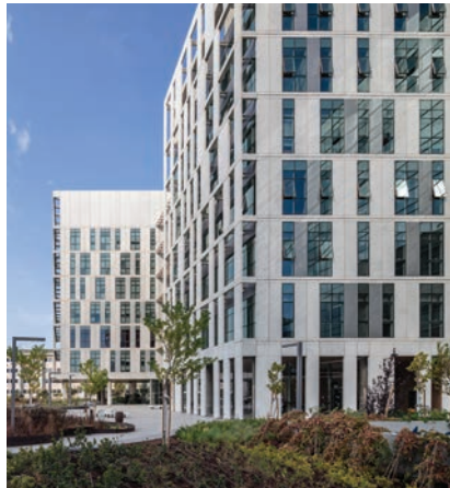
בנין משרדים גב ים רחובות. א. לרמן אדריכלים.
