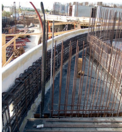
שלב ב' - הרכבה וקשירת ברזל
