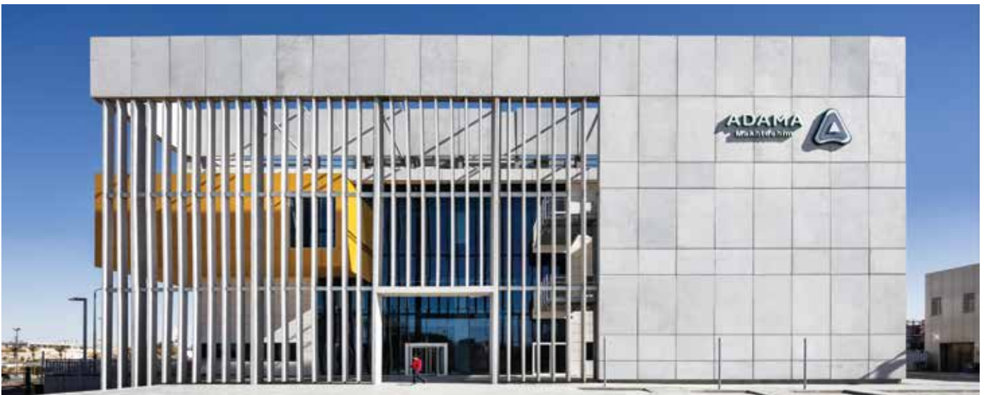
חיפוי מבטון אדריכלי, מכתשים רמת חובב מושלי אלדר אדריכלים.
