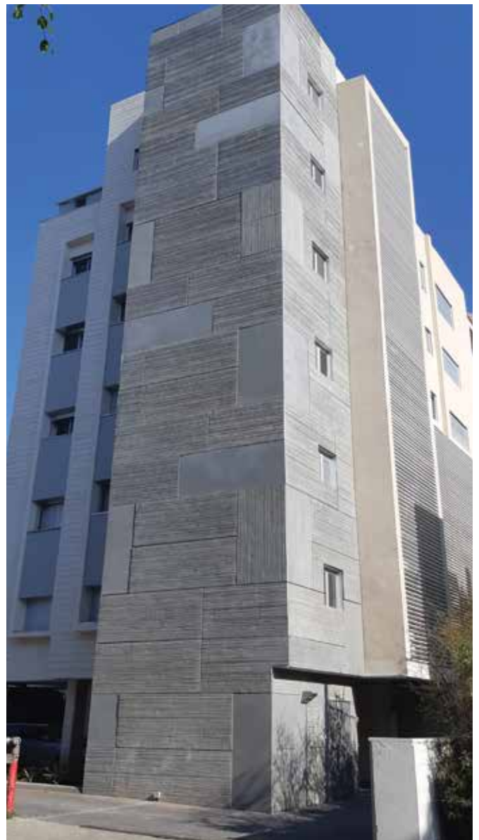
חיפוי UHPC, טשרניחובסקי, גיא אדריכלים הרצליה.
