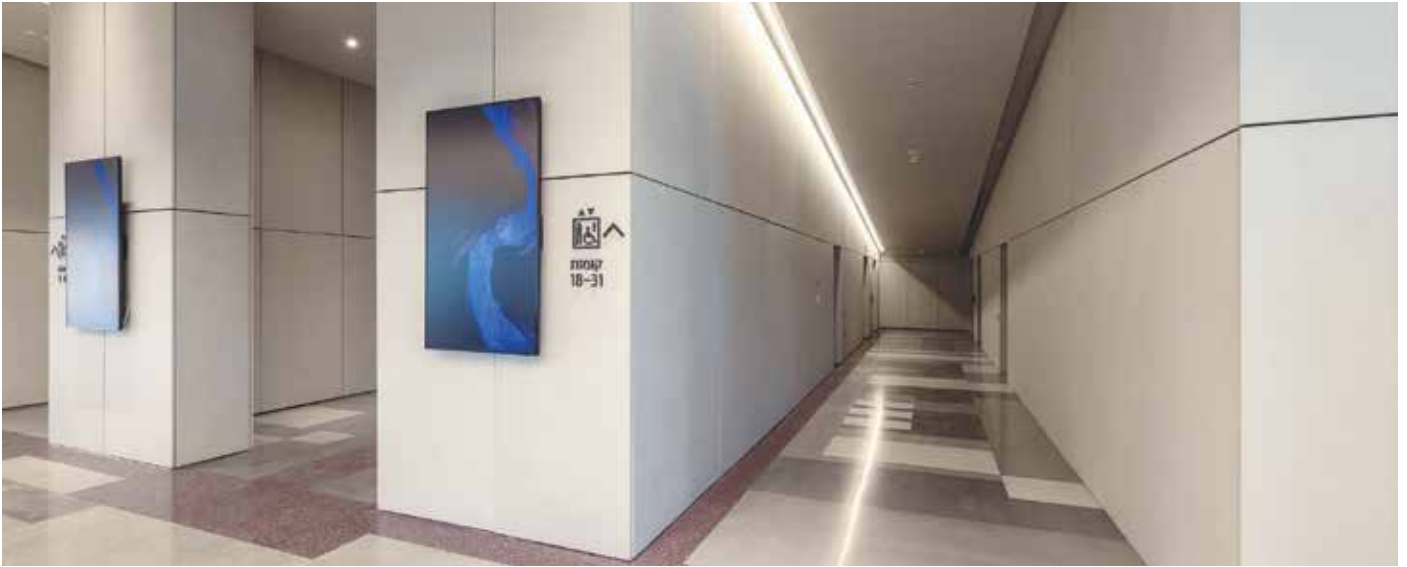
מגדל אקרו נדל"ן, ת"א, חיפוי לובי UHPC, אריחים מבטון אדריכלי מדוקק, ברנוביץ & גולדברג בשיתוף פיצו קדם אדריכלים
