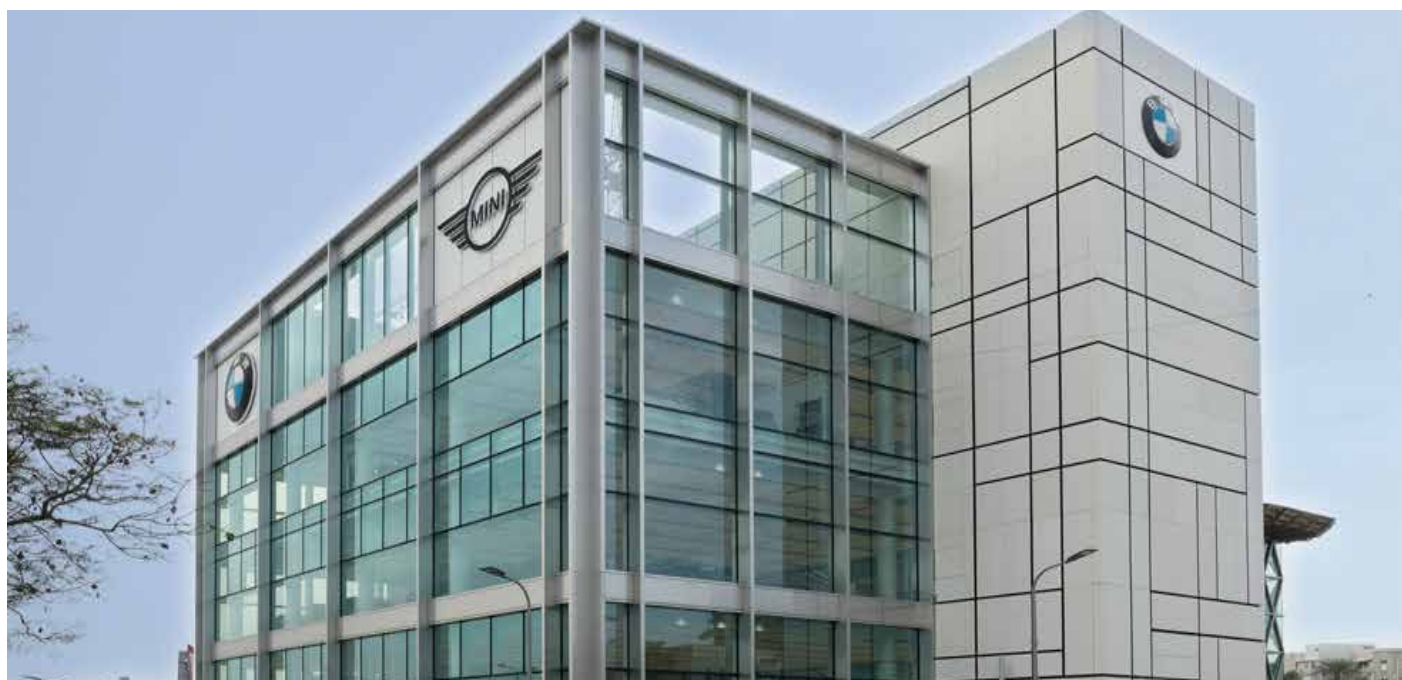
חיפוי UHPC, בניין BMW תל אביב, ישר אדריכלים.
