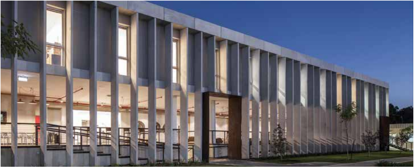
עמודים דקורטיביים בגובה 9 מ' מבטון אדריכלי, הקרייה האקדמית אונג, אדריכלות גל אור פישביין.
