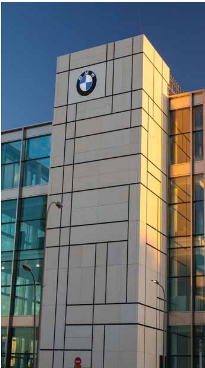
חיפוי UHPC, בניין BMW תל אביב, ישר אדריכלים.
