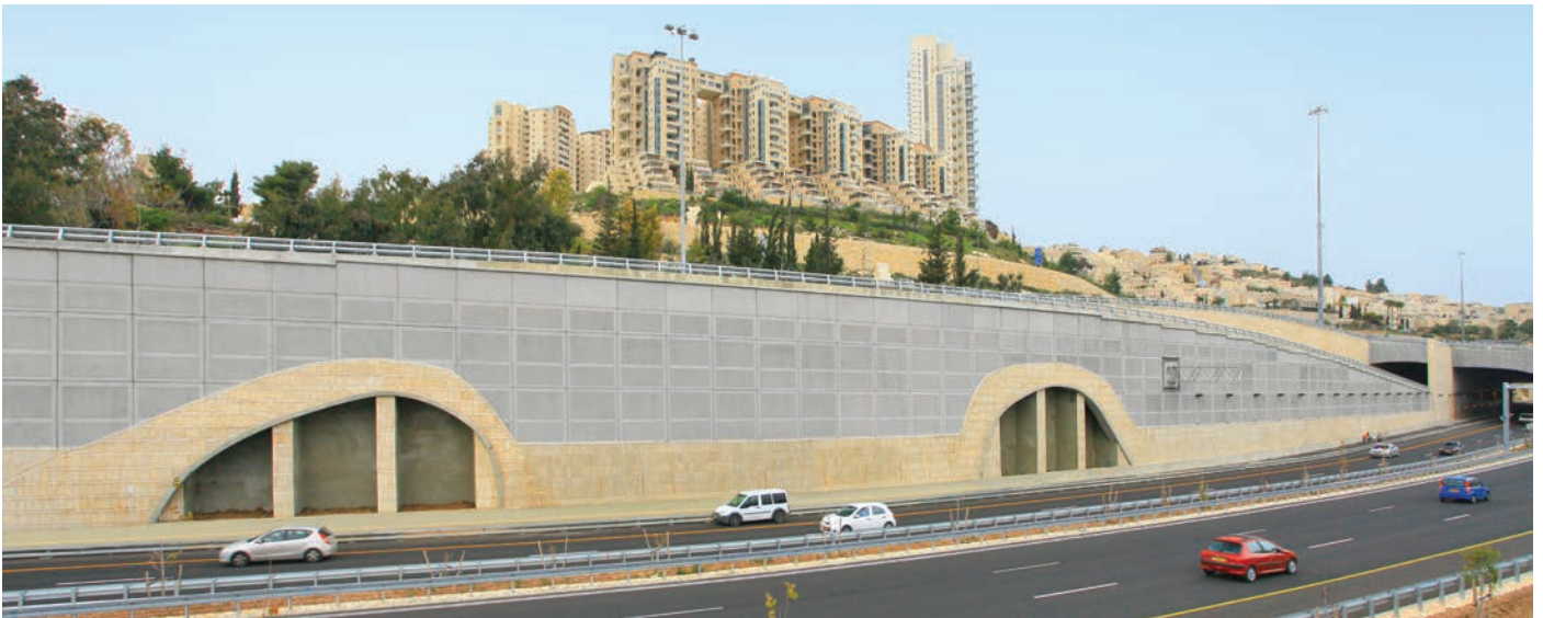
פלטות חיפוי דגם "גולומב", כביש 50, רחוב גולומב ירושלים. חמי גורלי אדריכל.
