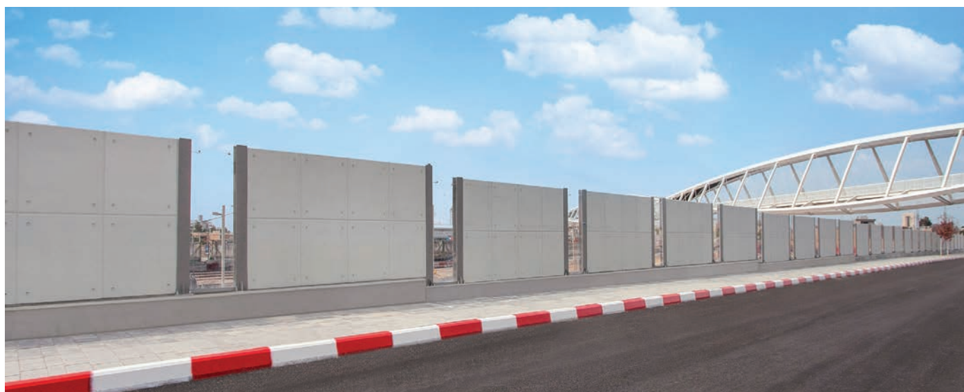
קיר "סונוליט" תחנת רכבת באר שבע. ברחנא אדריכלים.
