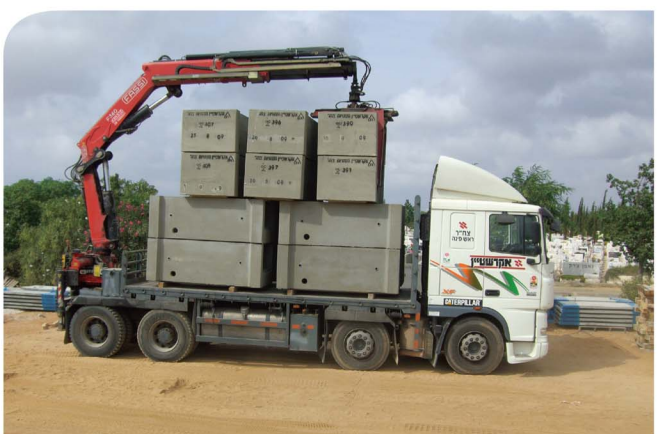
2. לאחר יציקת משטח הבטון, ייקבע מועד הרכבה עם נציגי אקרשטיין שילווח את הפרוייקט.
