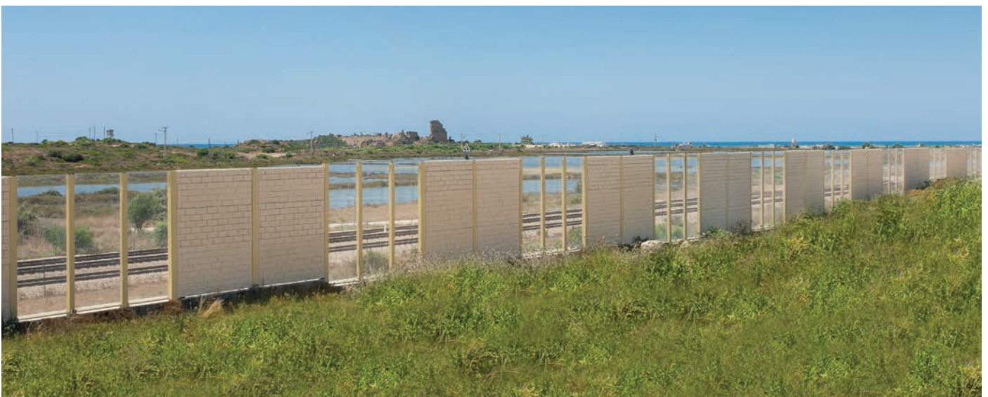
קיר אקוסטי "סונוליט" בשילוב חלונות. מתחם הרכס, עתלית. משה לנר אדריכלות נוף בע"מ.
