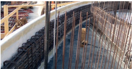
שלב ב' - הרכבה וקשירת ברזל
